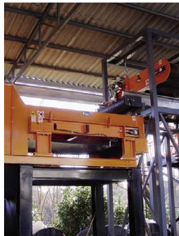
Wirbelstromabscheider (ECS) mit vorgeschaltetem Überbandmagnet.
