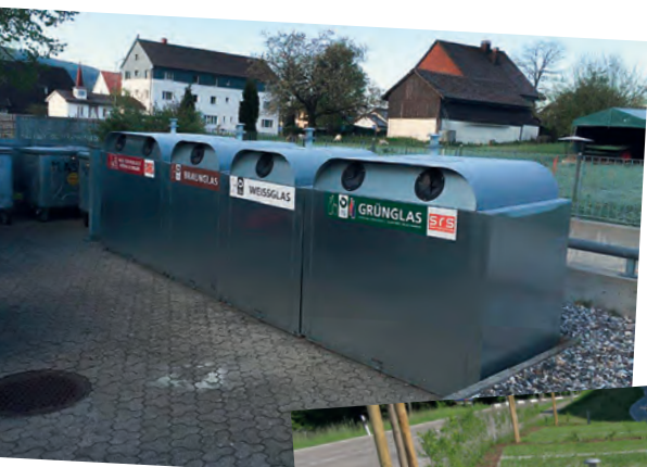
Glas- und Alucontainersammelstelle Typ C601 mit einem Volumen von 2 und 3 m 3 , in Rickenbach (SO).
