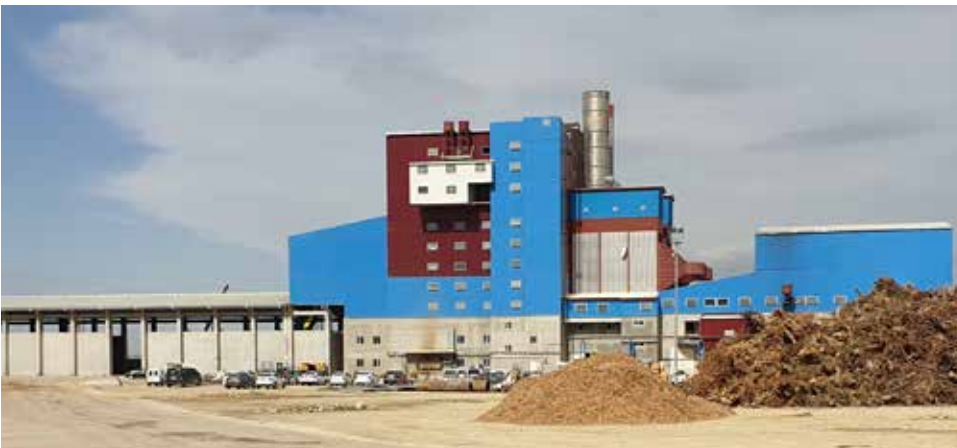
Das Biomassekraftwerk in Afyonkarahisar benötigt pro Tag rund 750 Tonnen an aufbereitetem Brennstoff.
