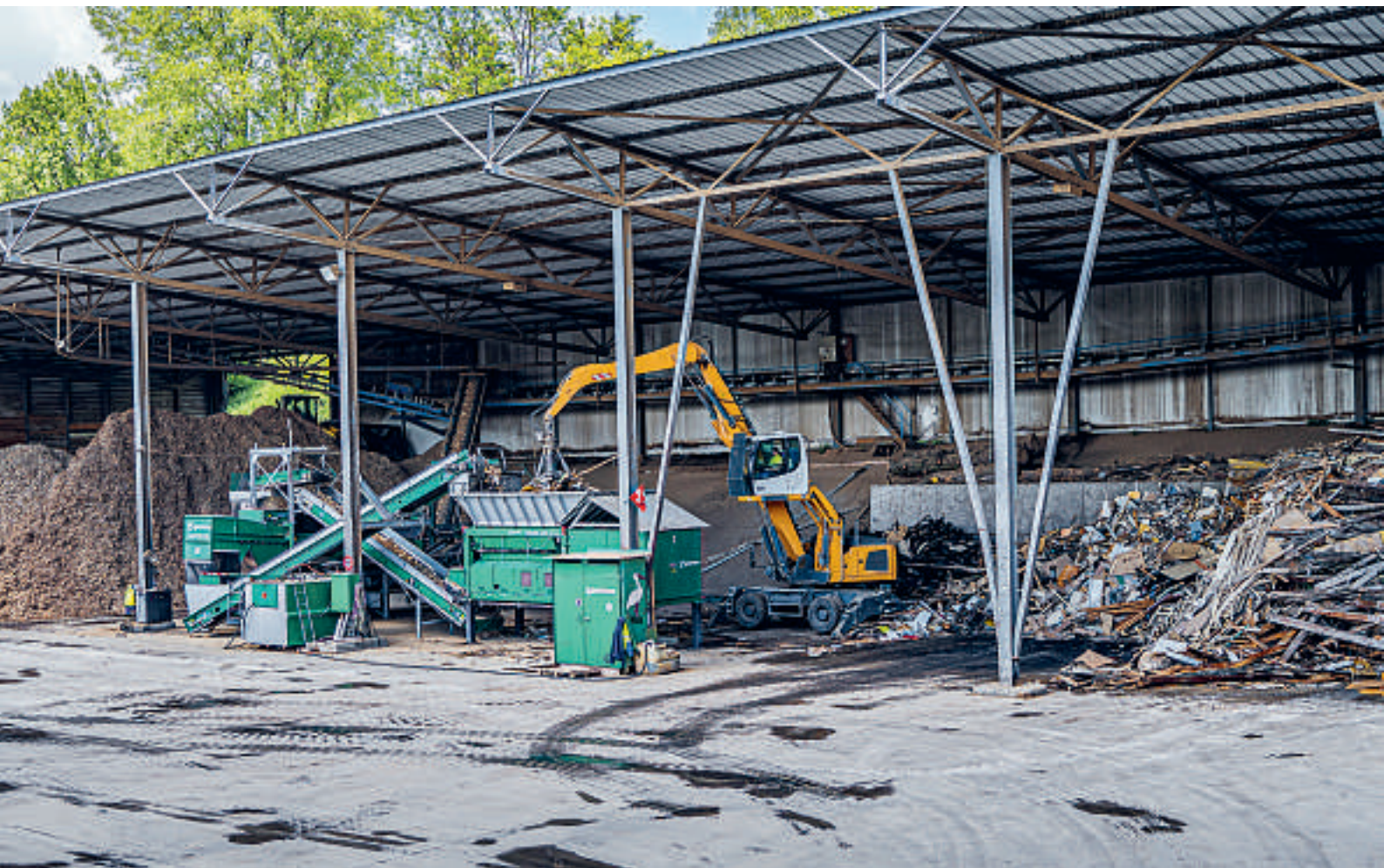
Rechts das Ausgangsmaterial, links der fertige Brennstoff und dazwischen die kompakte Aufbereitungsanlage.
