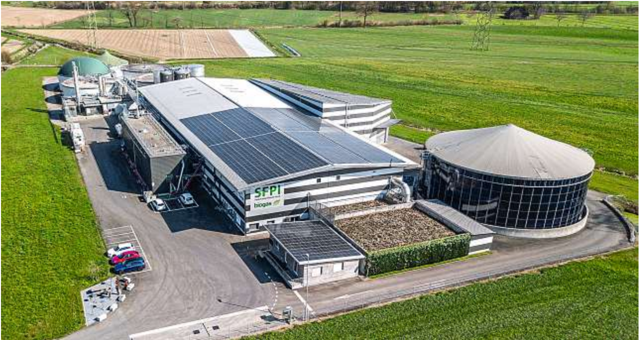
Feststoff- und Flüssigvergärungsanlage der SwissFarmerPower Inwil AG
