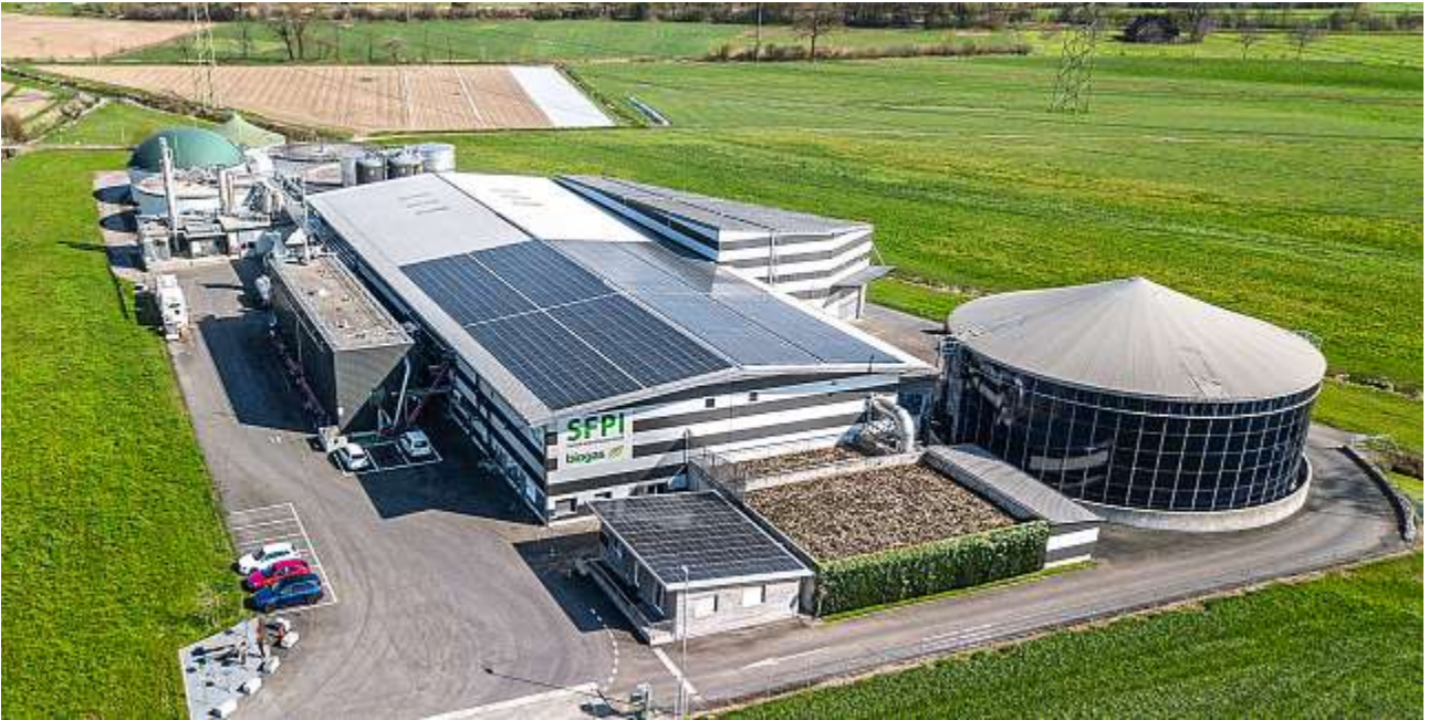
Installation de fermentation solide et liquide de la maison SwissFarmerPower Inwil AG
